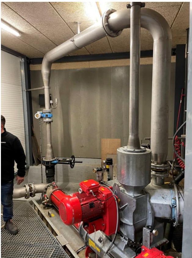
Bilde 1. Her pumpes husdyrgjødsel innom en separator som fjerner fremmedlegemer og flytendegjør husdyrgjødsel. Her blandes husdyrgjødsel også med de energirike bestanddelene. Foto: Martin Knoop
