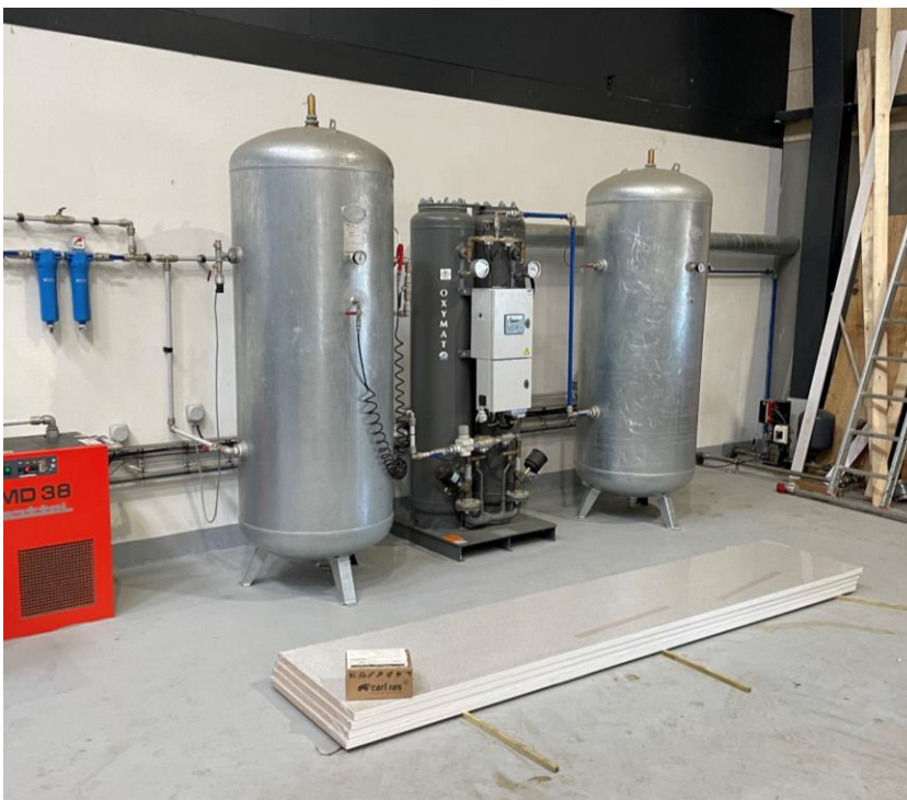
Bilde 4. Husdyrgjødsel går også gjennom en forbehandling, hvor man fjerner en del av svovelen ved hjelp av oksygen. Foto: Martin Knoop.
